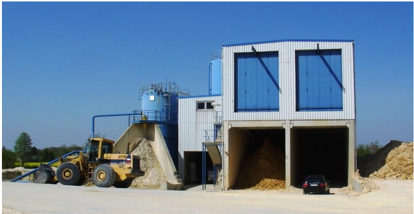
Abb.1: Kammerfilterpressenanlage zum Tonmineral- und Wasserrecycling
